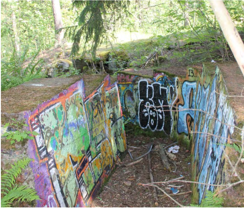
Kuva 5. Asema X:5 Pihlajamäki. Puolustusaseman maastonmuotoa portaittain mukaileva yhdyshauta on ainoa laatuaan koko linnoitusalueella. Betonoidut yhdys- ja taisteluhautojen seinät ovat useassa kohteessa
